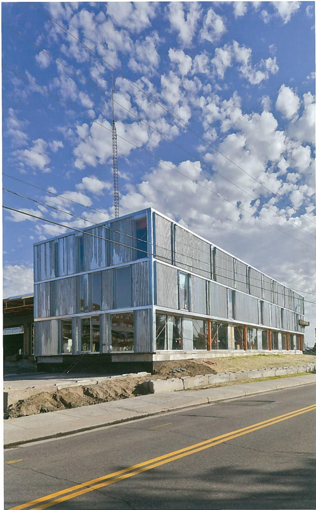
La antigua terminal de carga tenía un edificio cabecera de una planta con fachada de ladrillo cara vista. La reutilización de la fachada ha consistido en la sustitución de la obra de fábrica de ladrillo por una nueva mucho más ligera. Se han aprovechado elementos metálicos, combinados con huecos fijos de vidrio. Se ha construido un forjado intermedio y se ha elevado la altura de la cubierta.
